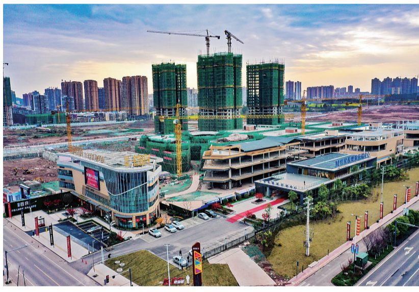
项目建设现场。
