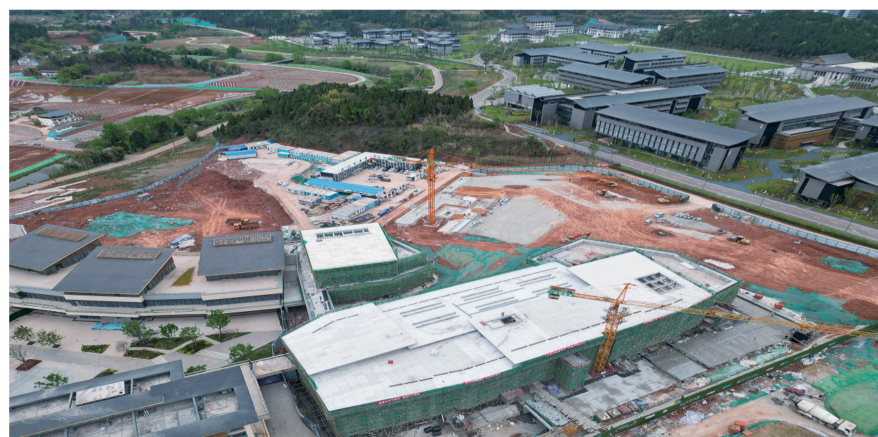
项目建设现场。
