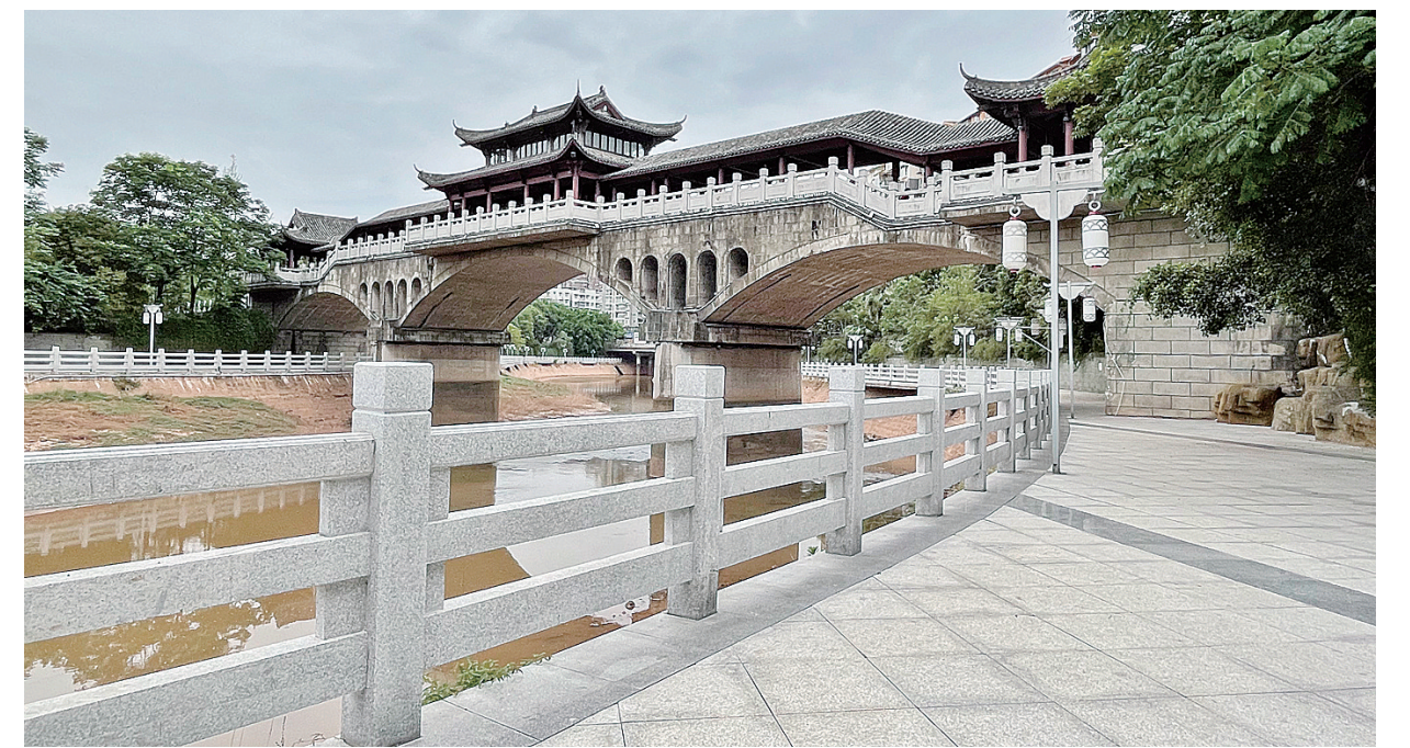
改造后的三贤文化公园亲水平台。
