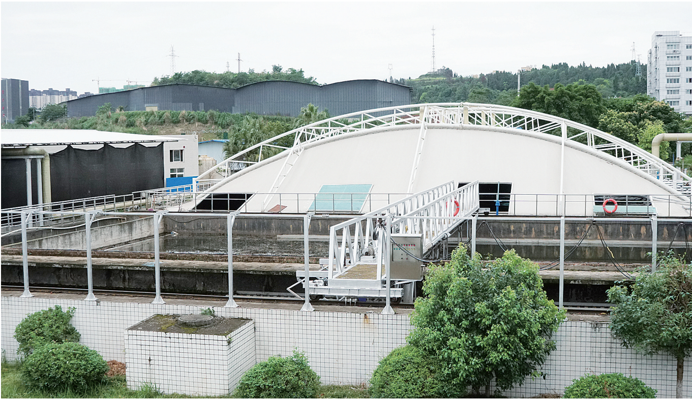
安岳县城市生活污水处理厂。
