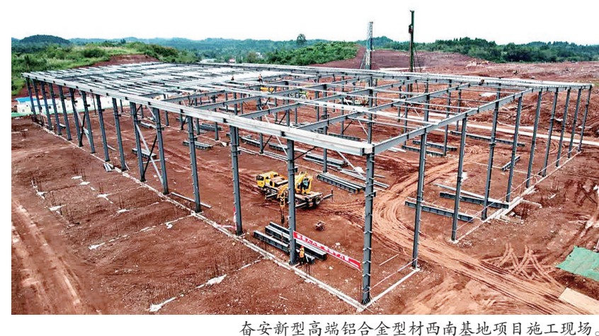
泰安新型高端铝合金型材西南基地项目施工现场。
