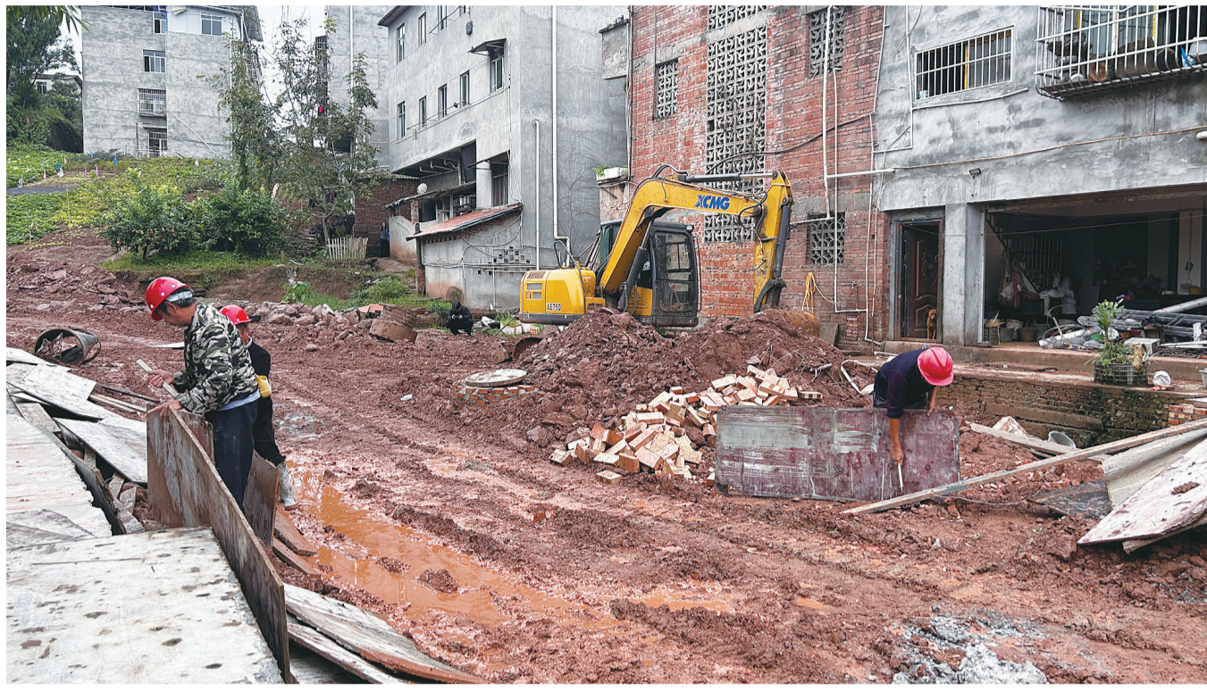
来凤乡绕场镇路项目施工现场。
