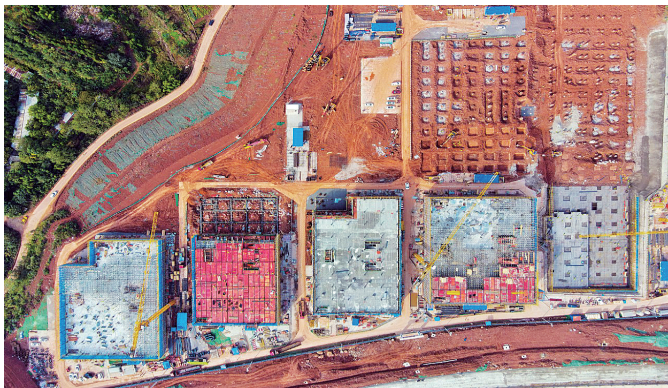
临空智能制造产业园(三草湾片区)项目建设现场。全媒体记者 张建摄
