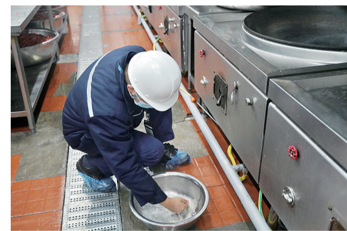
安检人员用肥皂水检测漏气点。
