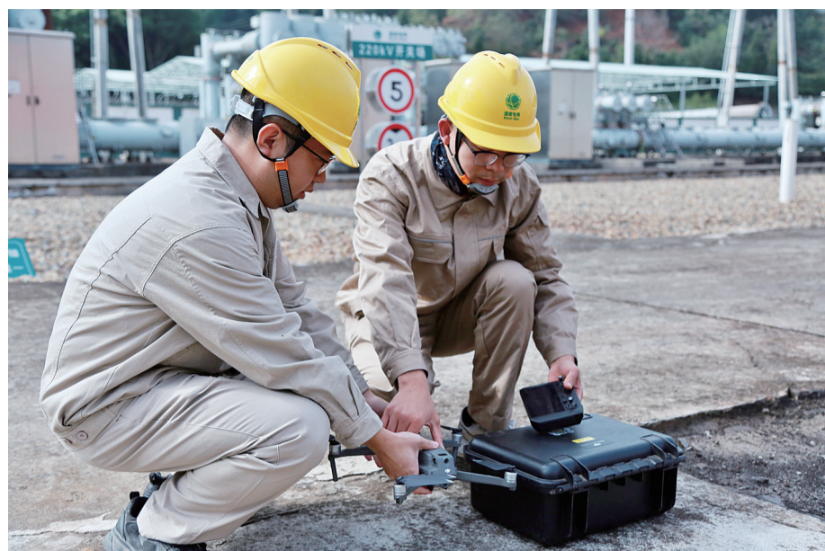
电力工人操作无人机巡视设备。
