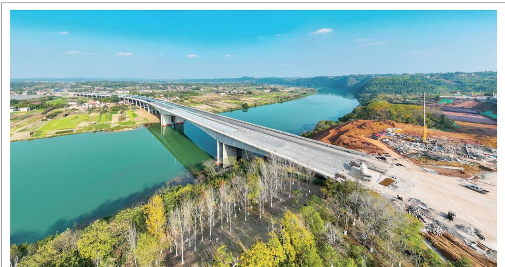
目前，董家坝沱江特大桥已合龙并完成主体工程，正在进行桥面铺装。该桥全长877.53米，是蜀都大道东延线简段建设工程（文龙寺至蜀乡大道段）的控制性工程之一。
