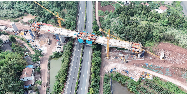
跨遂内高速特大桥（40+64+40）m跨高速段连续梁合龙。项目方供图
