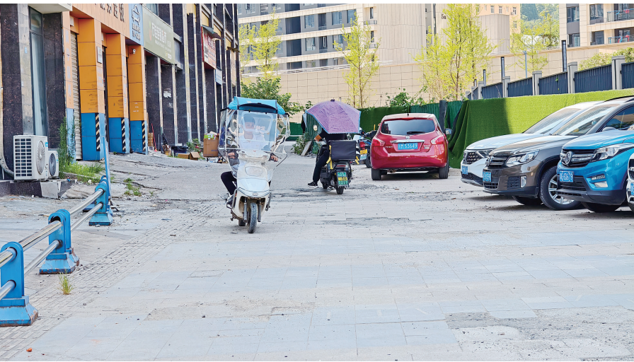
道路左侧为门市,右侧打着施工围挡,而且路面凹凸不平。
