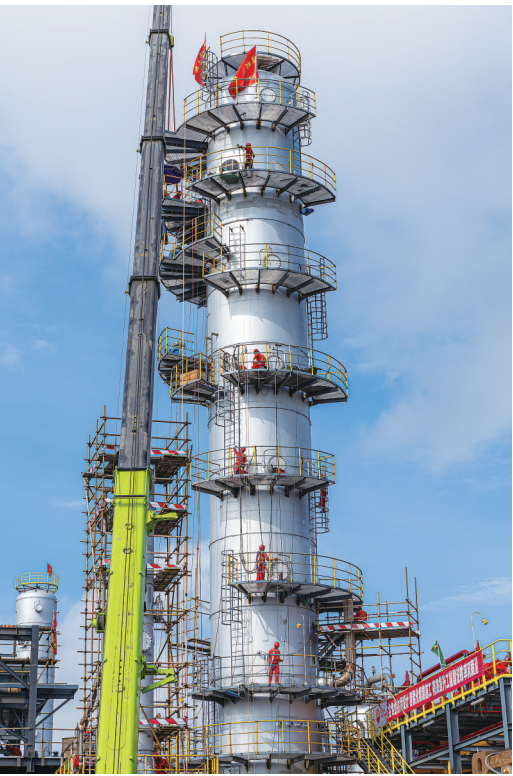
西南油气田安岳第二净化厂总投资约30亿元，规划用地480亩，建设2列日处理600万立方米的天然气净化装置。项目建成后年处理天然气可达40亿立方米，每小时可处理50万立方米天然气。该项目自2024年底动工以来进展顺利，目前14个大型塔器储罐、3台压缩机组及64个工艺模块等关键设备现场已全部安装完成，总体形象进度已完成81%，预计8月开展设备调试，9月投产试运行。
