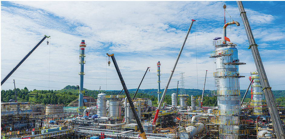
西南油气田安岳第二净化厂总投资约30亿元，规划用地480亩，建设2列日处理600万立方米的天然气净化装置。项目建成后年处理天然气可达40亿立方米，每小时可处理50万立方米天然气。该项目自2024年底动工以来进展顺利，目前14个大型塔器储罐、3台压缩机组及64个工艺模块等关键设备现场已全部安装完成，总体形象进度已完成81%，预计8月开展设备调试，9月投产试运行。
