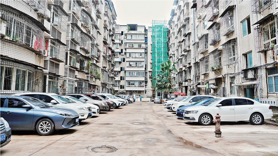
改造后的裕丰苑小区面貌焕然一新。
