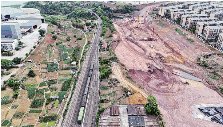
公铁物流港在建项目。
