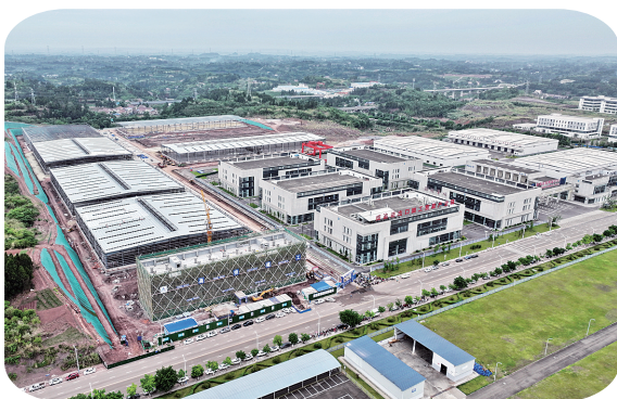
成渝中部（资阳）仓储物流基础设施建设项目。
