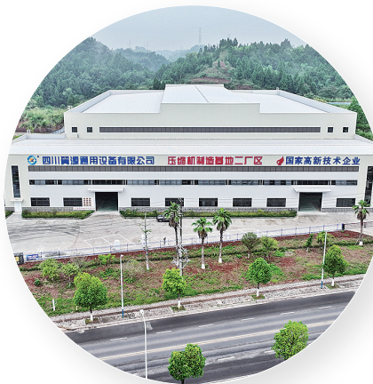
翼源通用设备公司项目。
