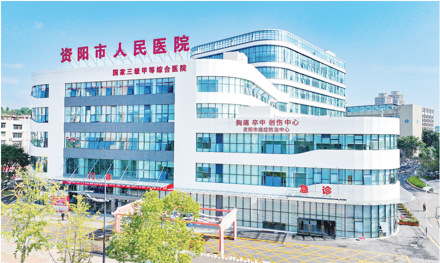
资阳市人民医院新门急诊大楼。张建 摄
