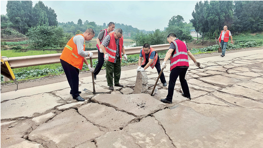
雁江区公路养护管理段对小堪路进行修补。(雁江区交通运输局供图)
